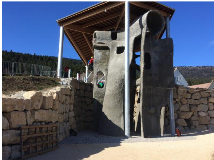
Vue générale de la structure (PB Laussac)
