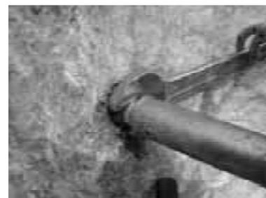
Il est très important de bien veiller à ce qu'il n'y ait pas de la résine sur le filetage : il faut prendre garde à bien essuyer l'excédent de résine qui reflue pendant la pose avant de dévisser le tamponnoir ou l'outil de pose.
